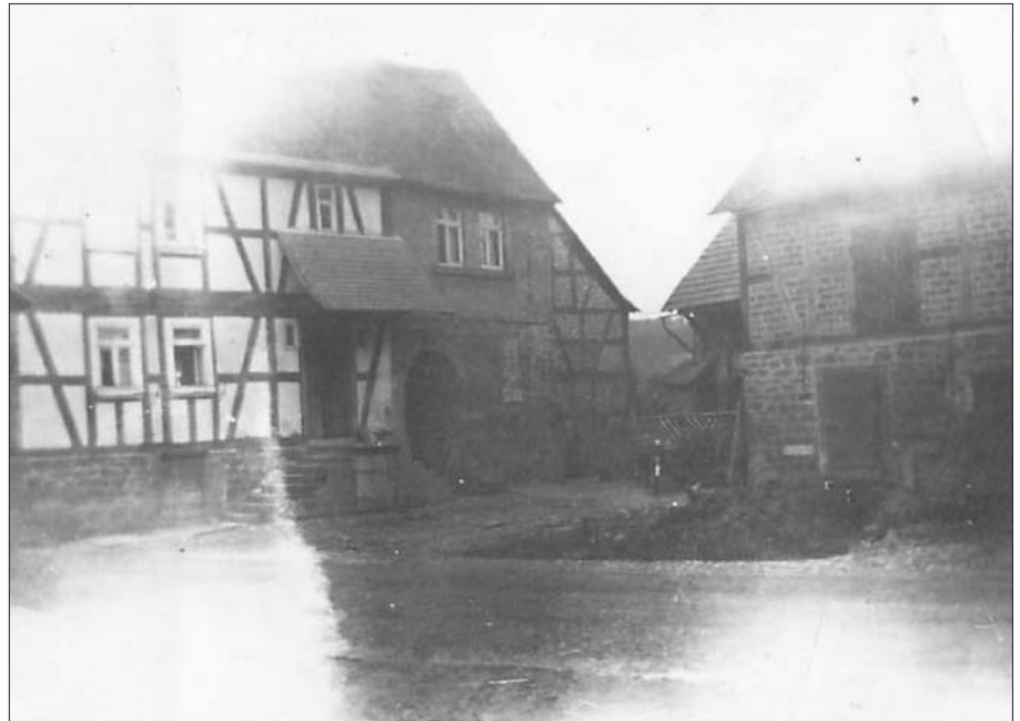
Abb. 184: Älteste Aufnahme der Thum'schen Hofreite, leider nicht in guter Qualität, aber besser als nichts! Die beiden Fenster unten links gehörten zur "Gouad Stuwwe". Der Treppenaufgang ist aus Sandstein. Durch die damals meist benagelten Schuhsohlen war er stark ausgetreten. Die durchaus kunstvoll gestaltete, zweiflügelige alte Haustüre wurde in den 1960er-Jahren durch eine "moderne" 08/15-Tür ersetzt. Deutlich abgegrenzt vom Wohnhaus mit den weißen Gefachen ist der Schmiede-Anbau. Gut noch erkennbar präsentiert sich der Torbogen als Eingang zur Schmiede. Über der Schmiede gab es ein weiteres Wohnzimmer. Das hinter der Schmiede zu sehende Fachwerk-Gebäude ist die heute abgerissene Hilger'sche Scheune. Das nur mit seiner linken Flanke erkennbare Gebäude im Hintergrund ist die 1927 erbaute massive neue Scheune. Der Misthaufen im Vordergrund rechts ist direkt an der Straße platziert. Das Gebäude hinter dem Misthaufen ist der von uns so genannte "Haaburrem" (Heuboden). Unter dem Heuboden befinden sich links der Außenkeller, der am Türsturz die Inschrift "HSH 1831" trägt, und rechts der Schweinestall. Die in Sandstein gemeißelte Inschrift bezieht sich auf die Vorbesitzer Hofmann.
