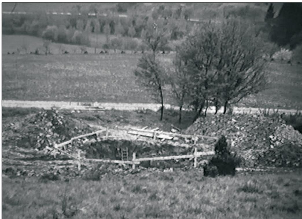
Abb. 12: Die Quellkammer musste vollständig ausgebaggert werden. Das kontaminierte Erdreich wurde abtransportiert.
